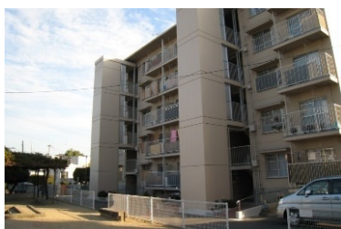
エレベーター設置（兵庫県営住宅）
